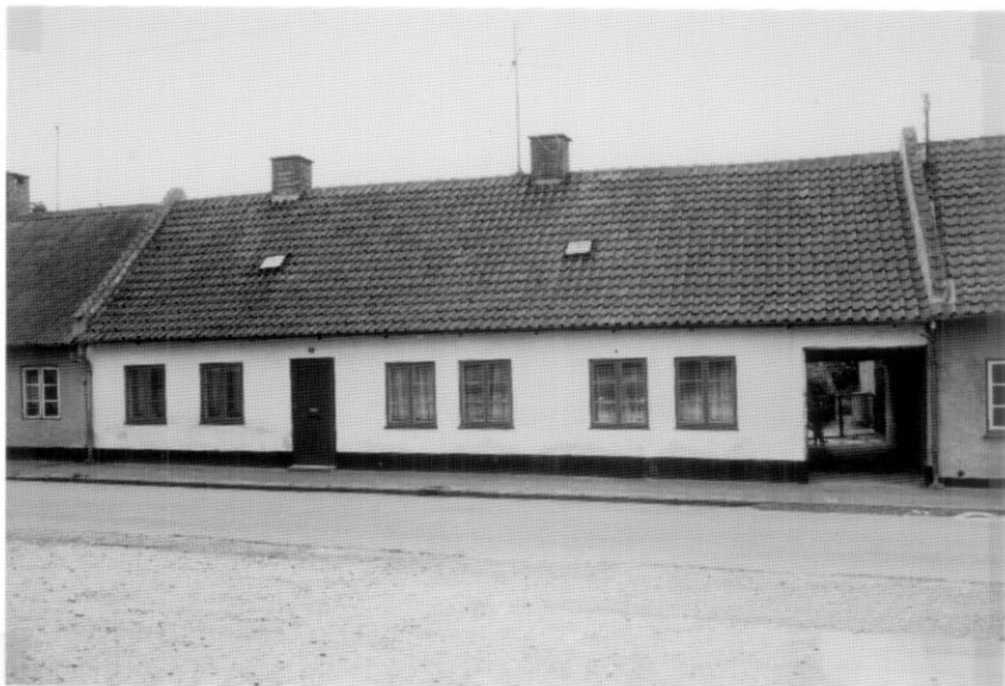
Valseværksgade 3, set fra nord
